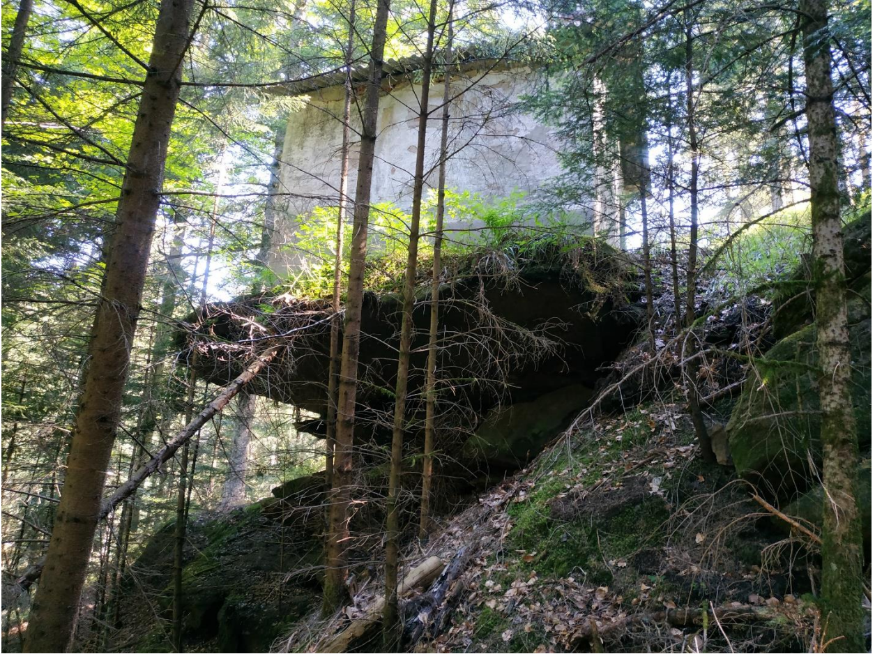
Illustration 25 - Habitation construite sur une zone en surplomb – Affleurement E3
